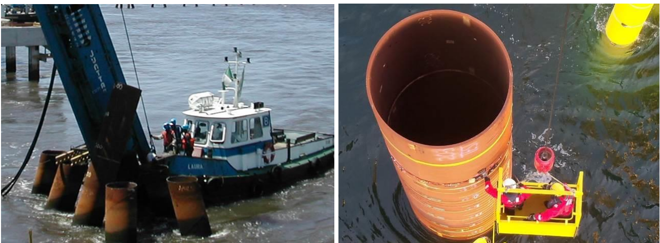
Abbildung 4: Zugänglichkeit des Pfahls für die Montage von Sensoren beim Nachrammen (links: vom schwankenden Boot, rechts: vom Mannkorb)
