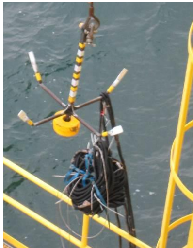
Abbildung 13: Bergung Messkabel für Restrike Tests
